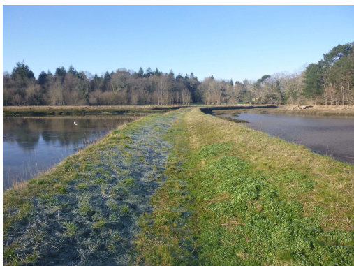
Photo 18: sente de la digue de Béquerel, février 2018 - ©Cerema
