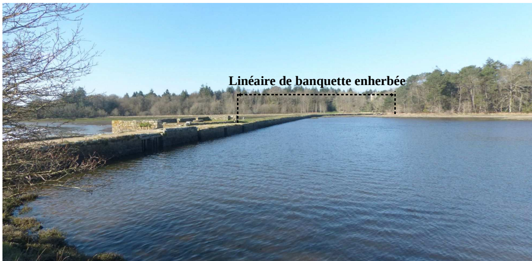
digue de Béquerel, vue générale
