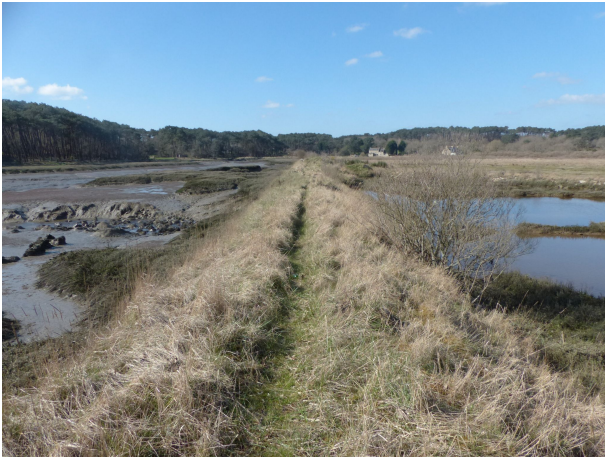
Photo 20: indice d'une sente en section NE de la digue de Lozèrez, mars 2018 - ©Cerema
