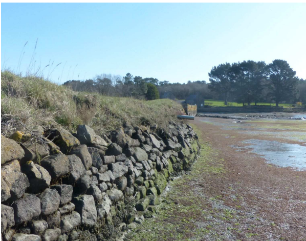
Photo 10: effet de ventre en aval de la banquette enherbée, mars 2018 ©Cerema
