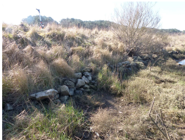
Photo 5: vue amont de la digue de Lozère, mars 2018 - ©Cerema
