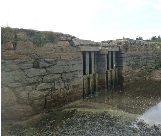
OH1 - vue amont des deux portes à mer
