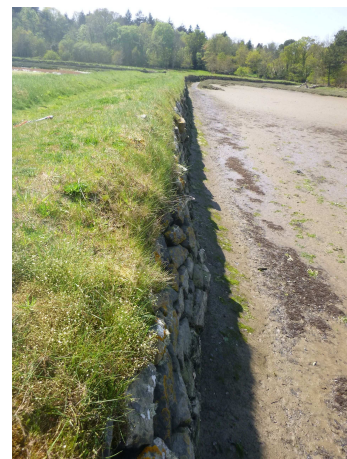
Photo 11: effet de ventre en amont de la banquette enherbée, avril 2018 ©Cerema
