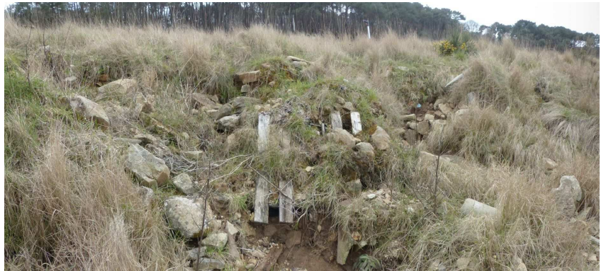
Photo 9: vue amont de la section en remblais, mars 2018 - ©Cerema
