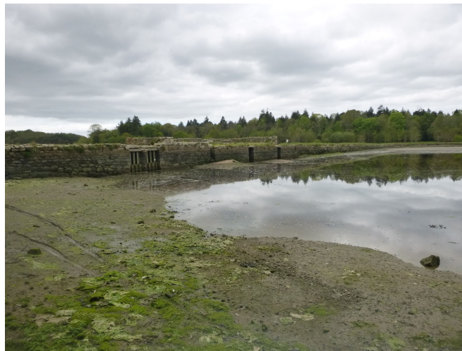
vue amont de la digue de Béquerel
