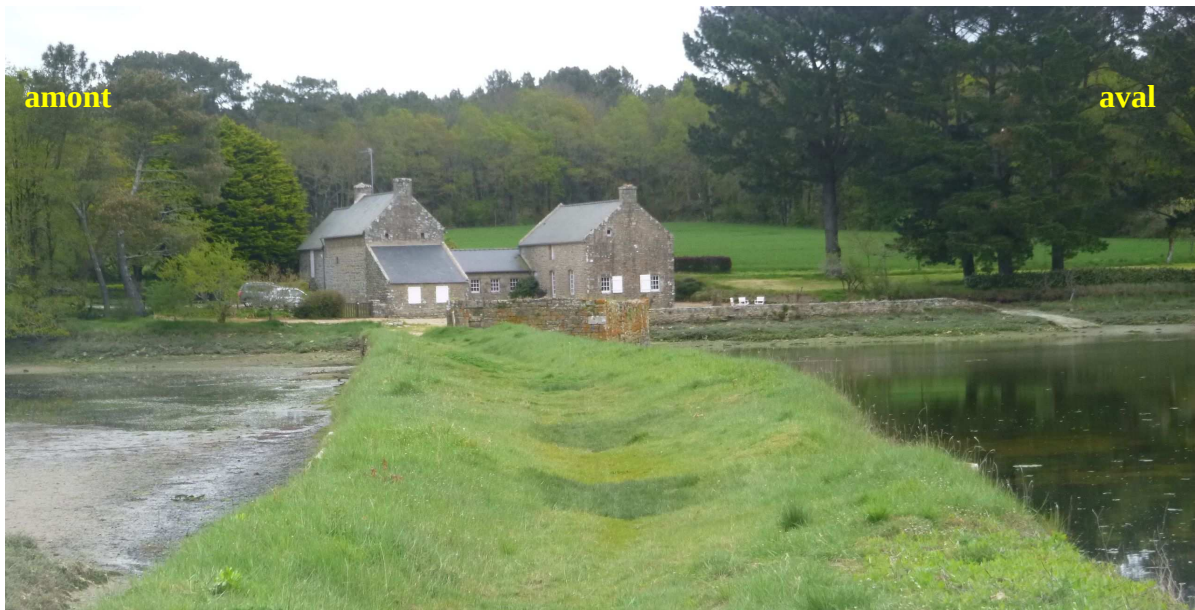
raccordement Est de la digue de Béquerel
