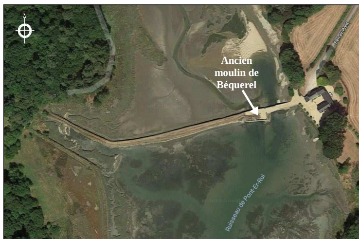
Digue de Béquerel - ©2018 Google
