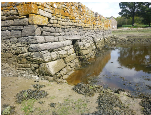
ancien moulin de Béquerel vue aval
