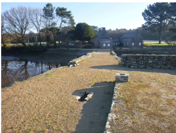
Photo 1: fondation du moulin de Béquerel et raccordement rive Est, février 2018 - ©Cerema
