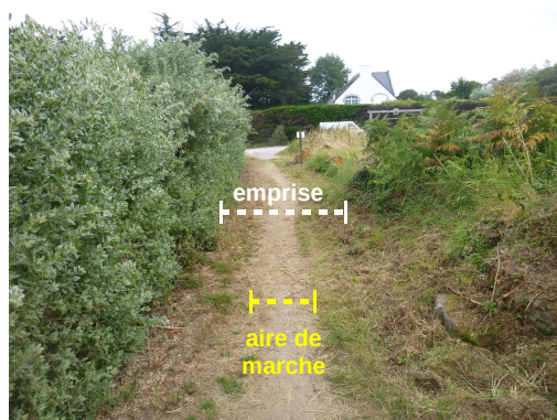
Photo 17: définition de l'aire de marche et de l'emprise
