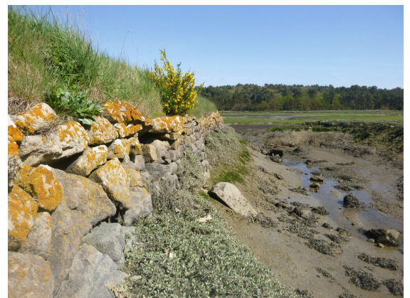
plant de genêt, section Ouest
