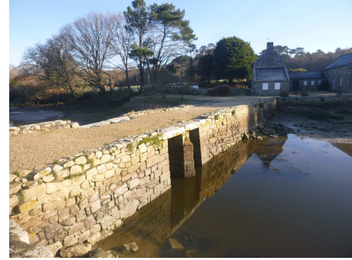
mur aval et portes à mer
