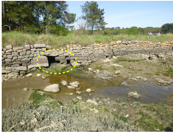
OH4 - trop-pleins vue aval
