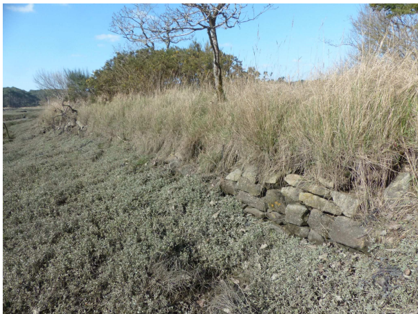
Photo 4: vue aval de la digue de Lozère, mars 2018 - ©Cerema
