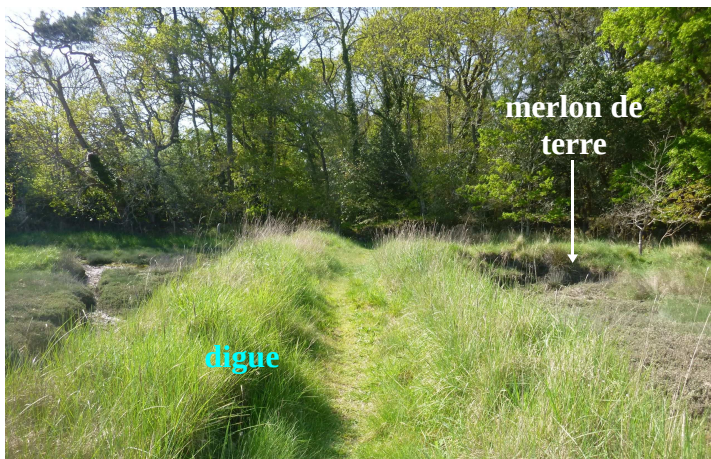
raccordement NW de la digue par un merlon de terre
