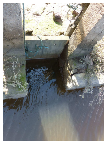
Photo 7: vue amont de la vanne de la digue de Lozère, mars 2018 - Cerema
