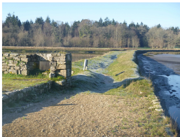
Photo 2: délimitation digue nivelée - digue enherbée, février 2018 - ©Cerema
