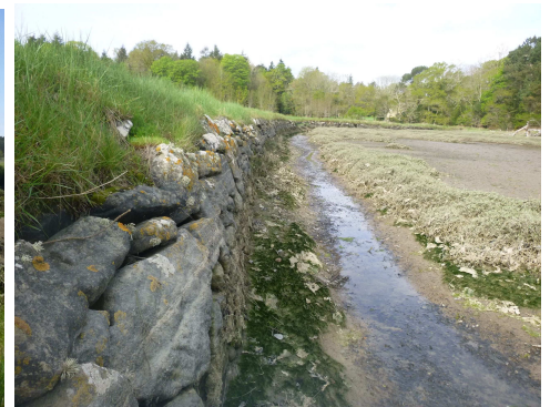
vue amont de la banquette enherbée
