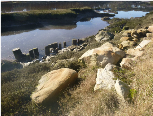
Photo 8: système de confortement pieux hydrauliques/enrochements, février 2018 - ©Cerema
