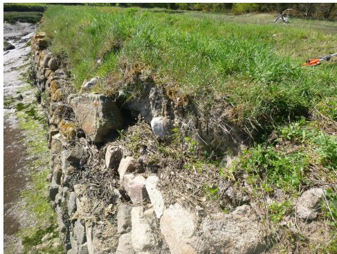
vue aval de la banquette enherbée
