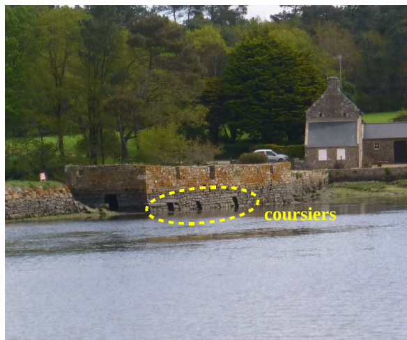
OH2 - vue aval des trois coursiers de l'ancien moulin de Béquerel
