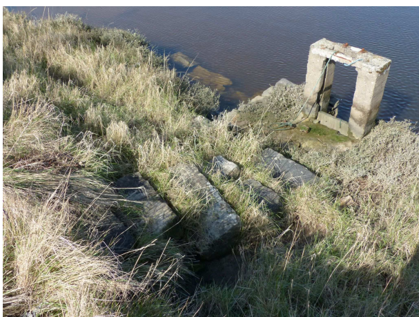
Photo 6: vue amont de la vanne de la digue de Lozère, mars 2018 - Cerema
